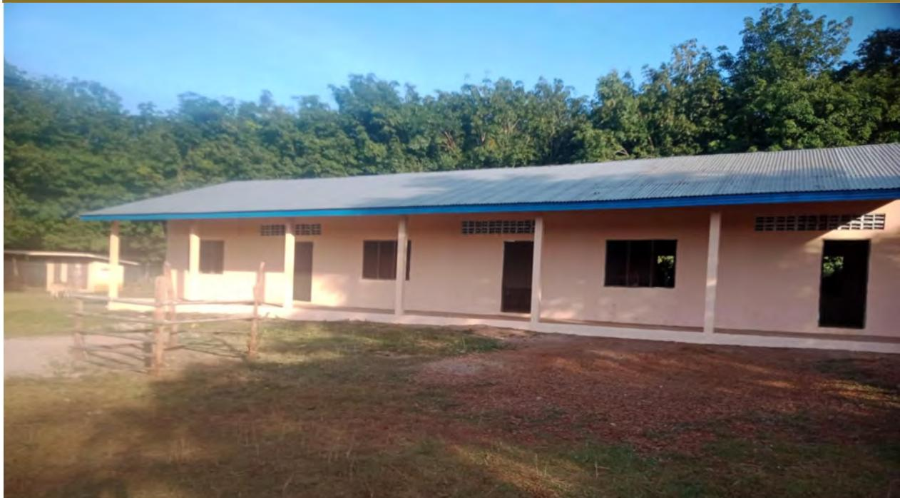
La construction de l'école neuve de Ban Di Tissip a bien avancé: murs, toit, huisseries sont terminés et les élèves occupent déjà les classes. L'école est reliée au réseau électrique, les WC sont construits, le château d'eau est installé .
